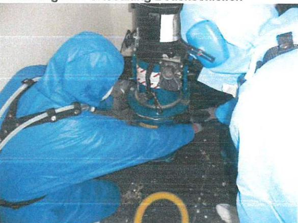
Abbildung 30: Tonne vom Sauger lösen
