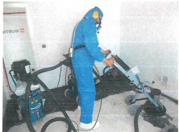
Abbildung 47: Weiter Bodenschleifen
