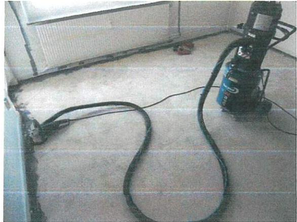
Abbildung 39: Angeschlossene Handschleifmaschine
