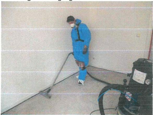
Abbildung 43: Absaugen der Bodenfläche
