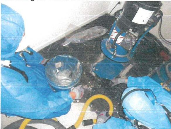
Abbildung 34: Einlegen eines neuen Beutels
