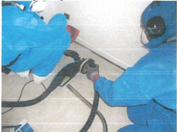
Abbildung 41: Reinigung der Handschleifmaschine
