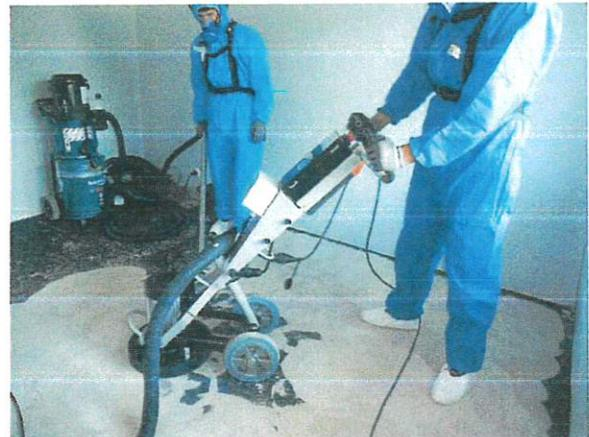
Abbildung 63: Fortsetzen Bodenschleifen
