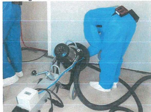
Abbildung 65: Absaugen der Schleifscheibe
