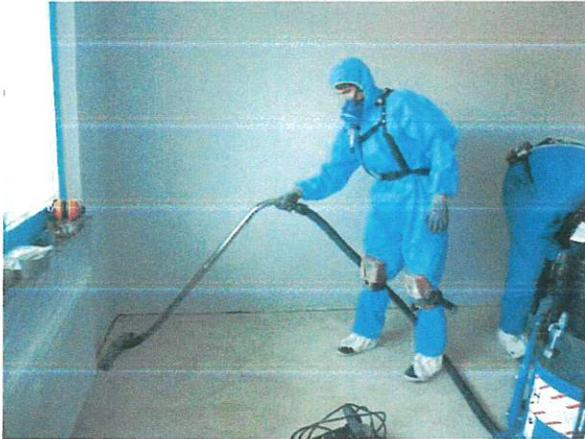
Abbildung 74: Absaugen der Bodenfläche
