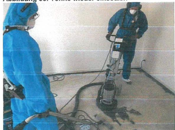
Abbildung 37: Ende Bodenschleifen
