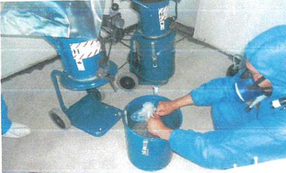
Abbildung 50: Beutel verschließen m. Kabelbinder
