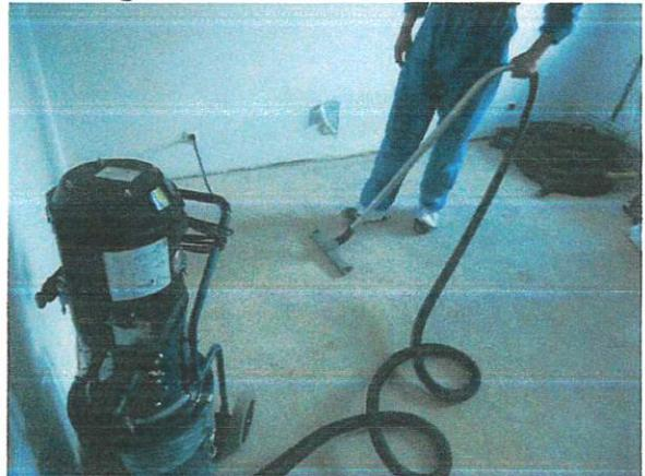
Abbildung 61: Absaugen der Bodenfläche
