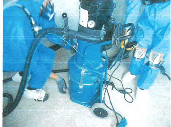
Abbildung 69: Ende Beutelwechsel
